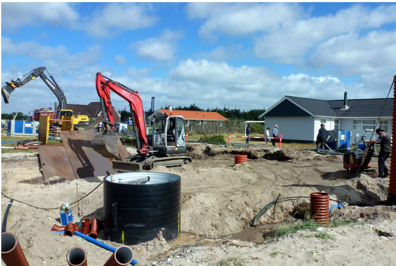
Den dybe kloakpumpestation ved Themisvej er endelig på plads – efter meget stort arbejde med at sænke grundvandsstanden.
