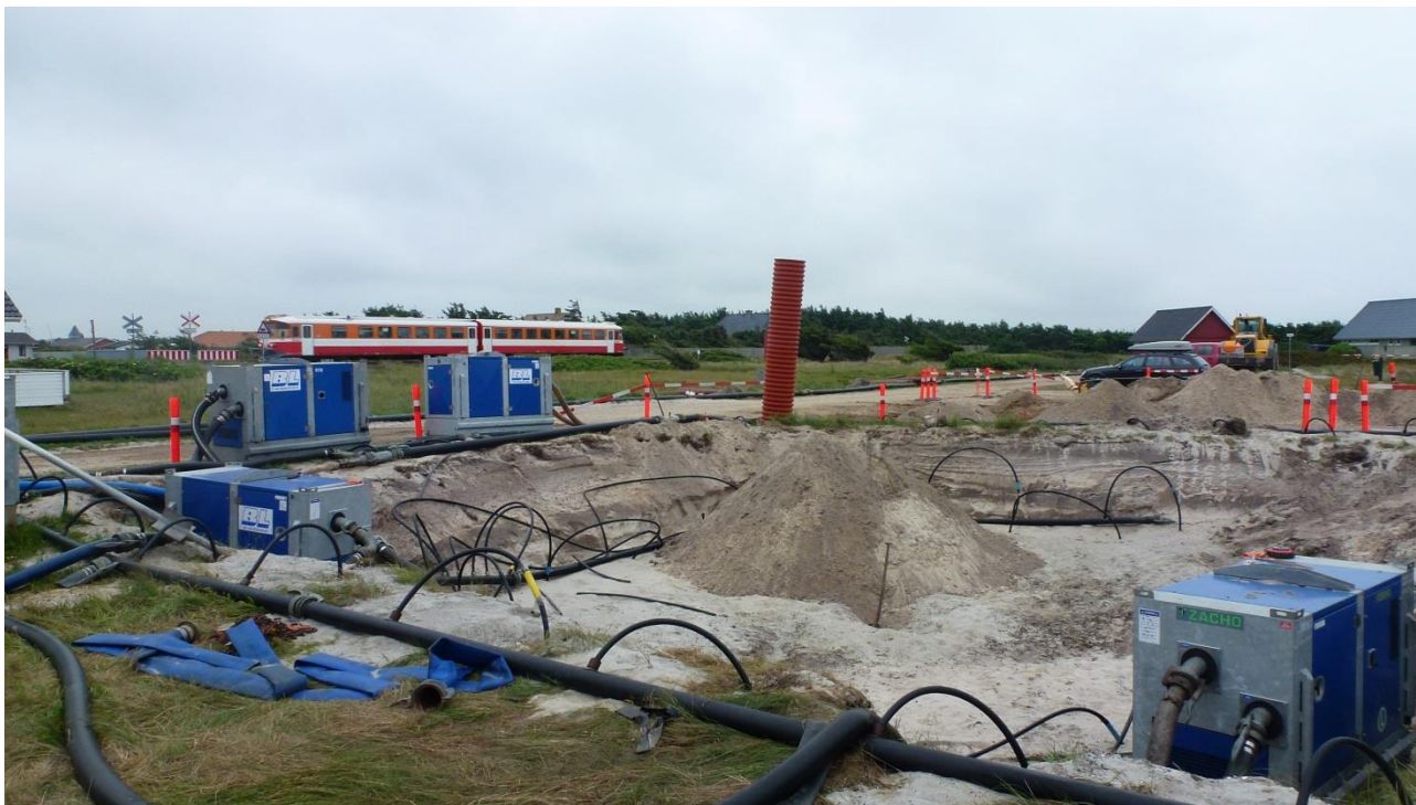
Figur 1. Ved Themisvej 6 - påbegyndt udgravning for placering af pumpestation.
