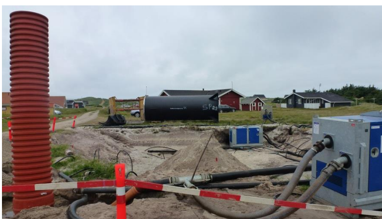
Figur 1. Ved Themisvej 6 - påbegyndt udgravning for placering af pumpestation.
