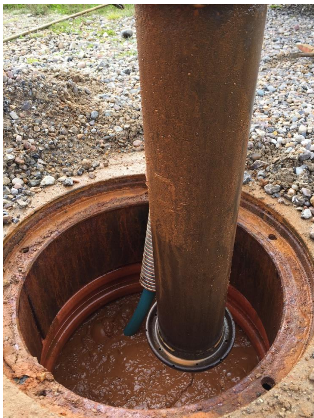
Rensebrønd med igangværende spuling af dræn.
