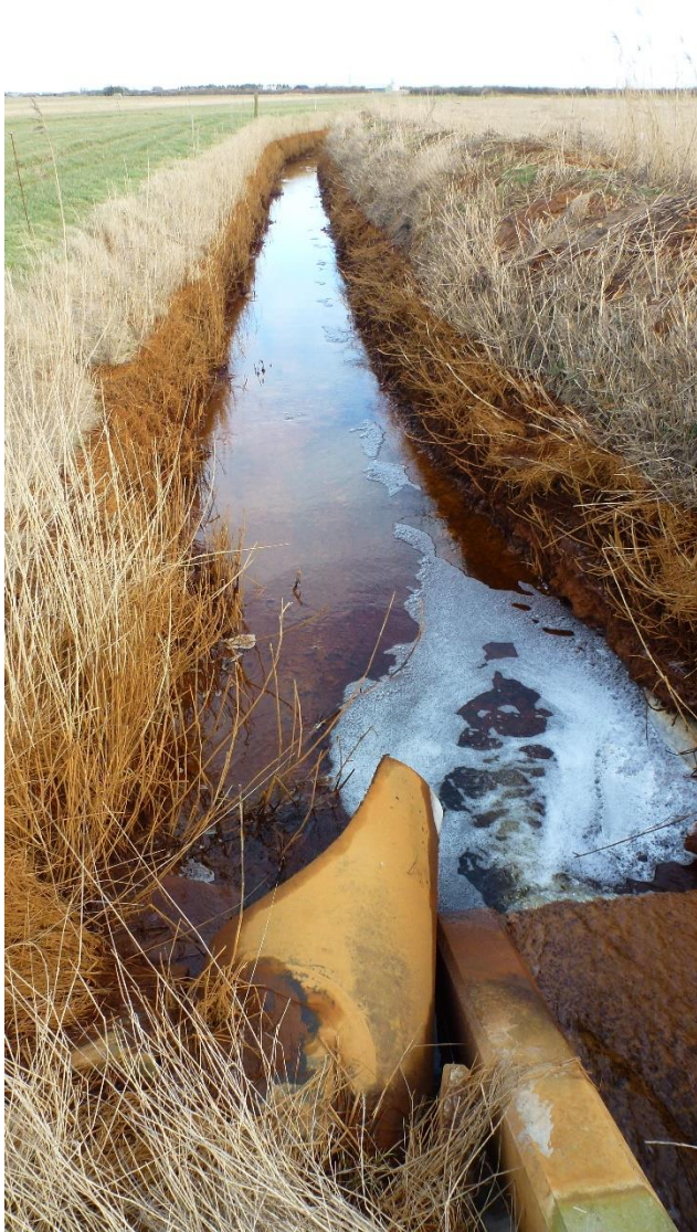
Her ses udløbsbygværket for afledning af drænvand
