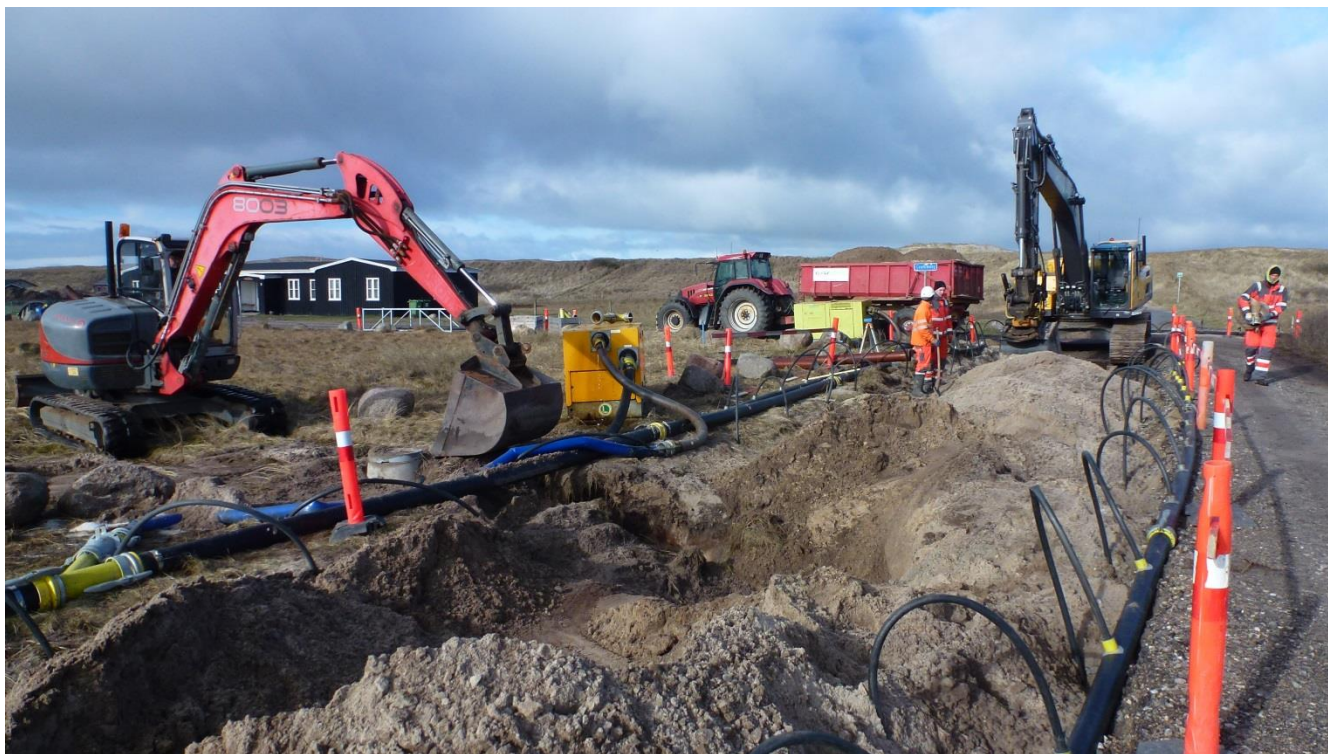
Fra opgravningen ved Bragdøvej.
