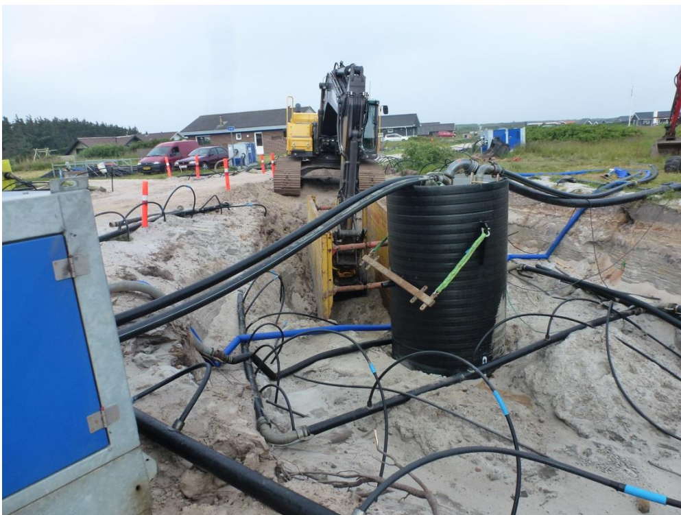
Yderligere en pumpestation placeres
