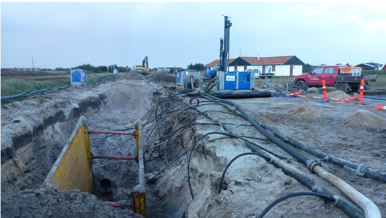
Opgravning i John Brights Vej fra Horizonvej mod Hvilehjemsvej
