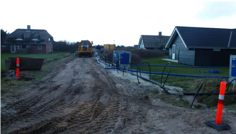
Der har været gravet i stikvejen Fourmivej 18 – 30
