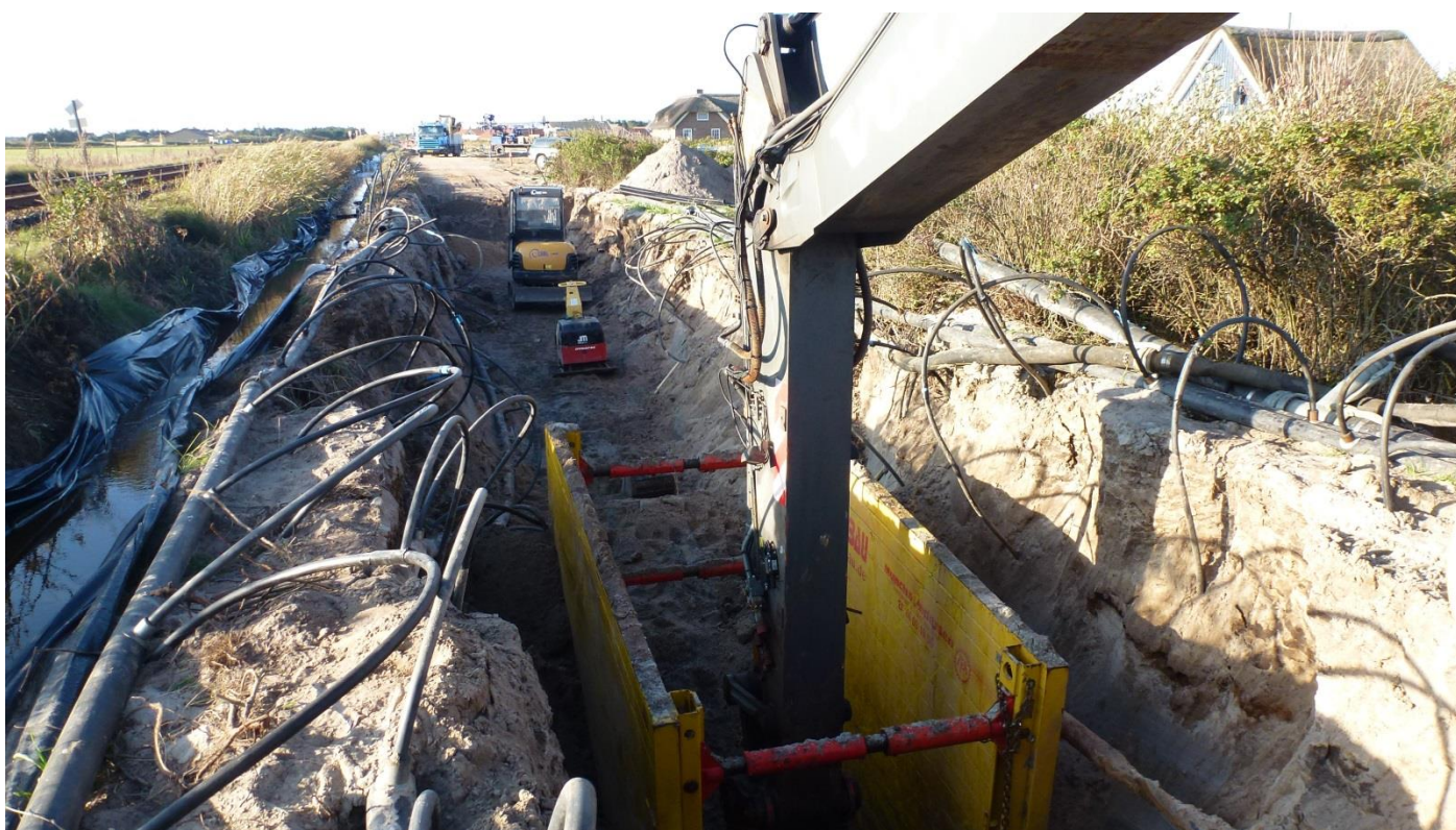
Med forholdsvis store dybder og i sandet jord med masser af grundvand, mange sugespidses, rør for afledning af vand og flere pumper, er der tale om ret vanskelige arbejdsforhold.
