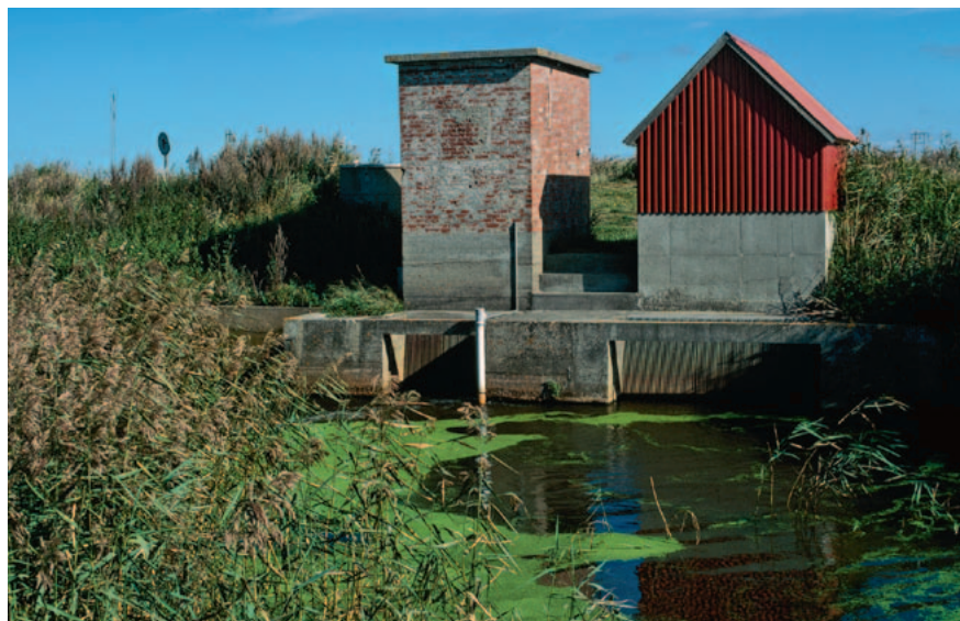
Pumpestationen, der trækker drænvandet ud fra Sandholm Nor, står oppe i det nordøstre hjørne, lige bag Thyborøn Kommunes Genbrugsstation. Det grønne vand i pumpekanalen viser, hvor overgødsket egnen er. Foto: 12. sept. 2005.
