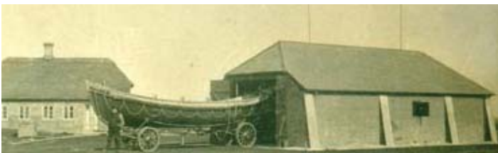
Redningsstationen 1847, nu nedrevet
